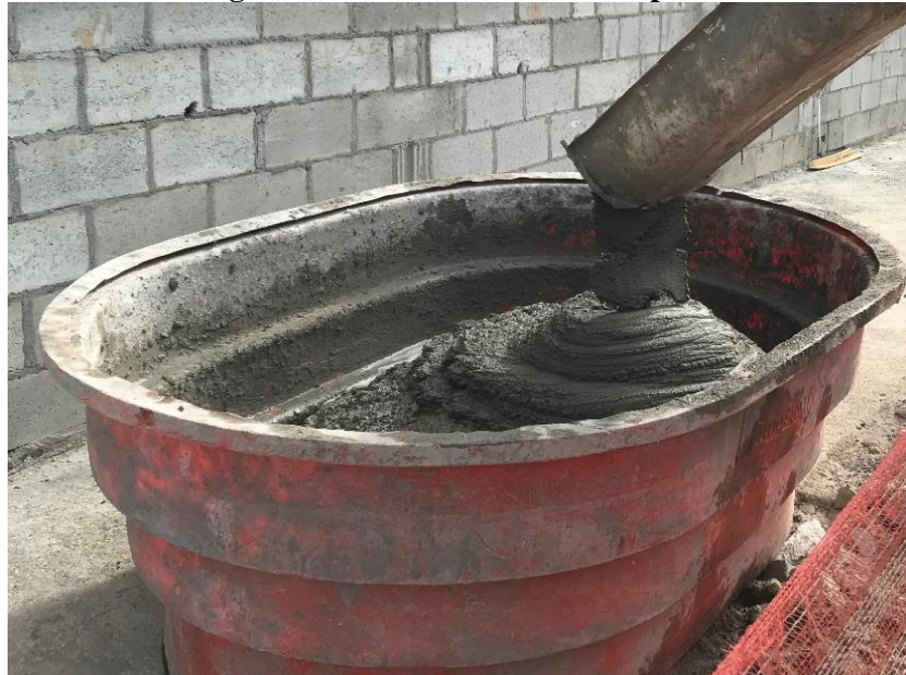
Figura 3 - Recebimento de argamassa estabilizada em caixa plástica no canteiro de obras
